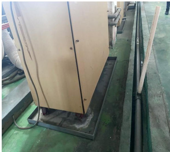
电镀车间围堰
