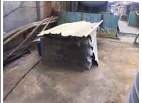
硫酸储罐旁应急沙
