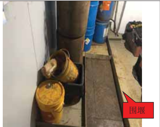
危废暂存间局部围堰图
