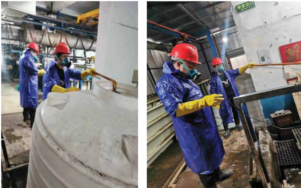
图2 抢险队员正将水泵放于镀槽内抽取镀液至应急储存罐
