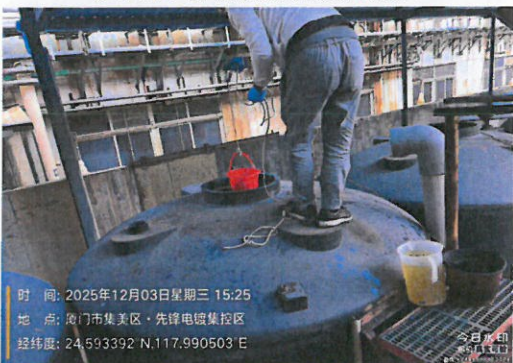
DW003 含氰废水排放口进口
