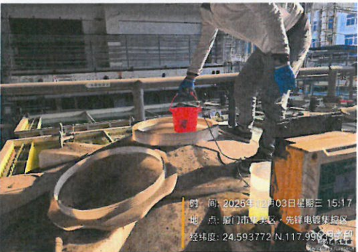
DW001 含镍废水排放口进口
