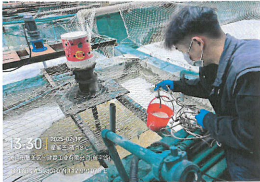
油脂处理设施进口
